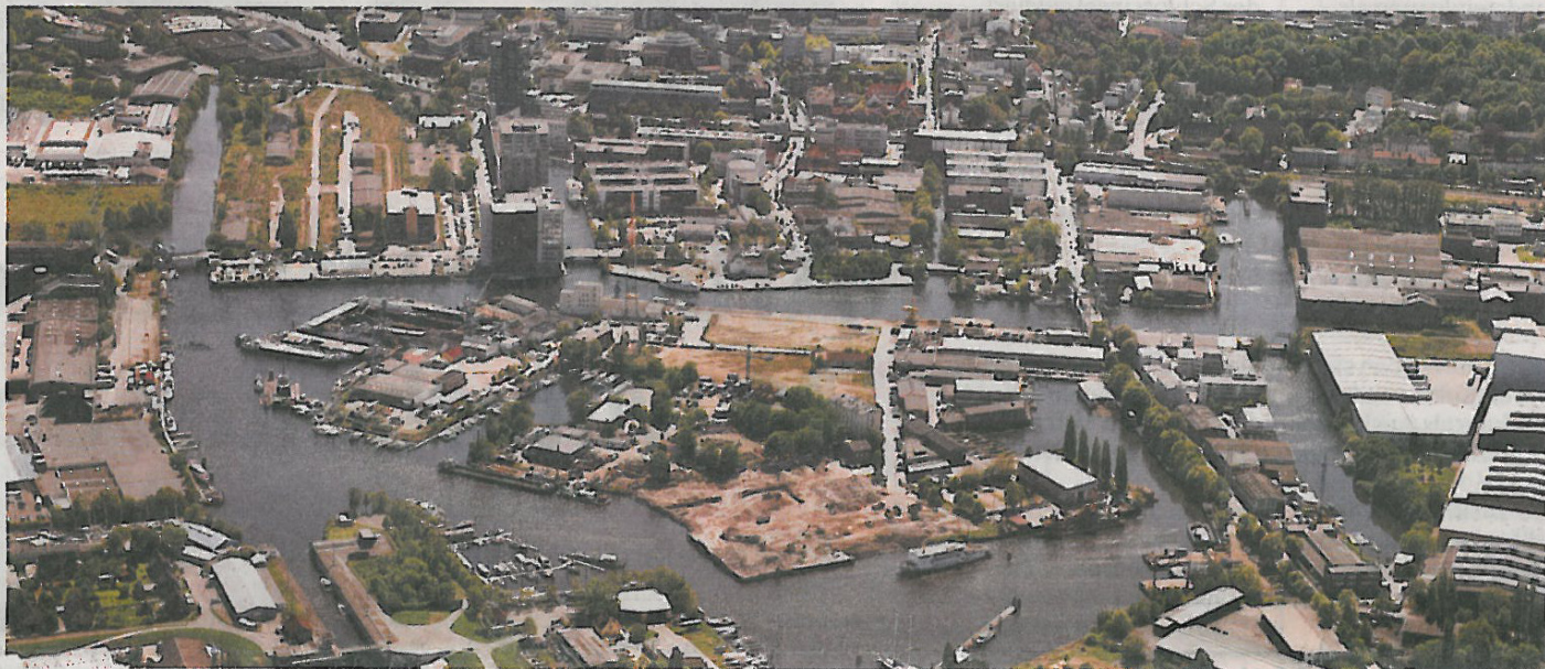
Die Harburger Schlossinsel aus der Luft: Hier entsteht ein neuer Harburger Stadtteil mit 180 Wohneinheiten.
