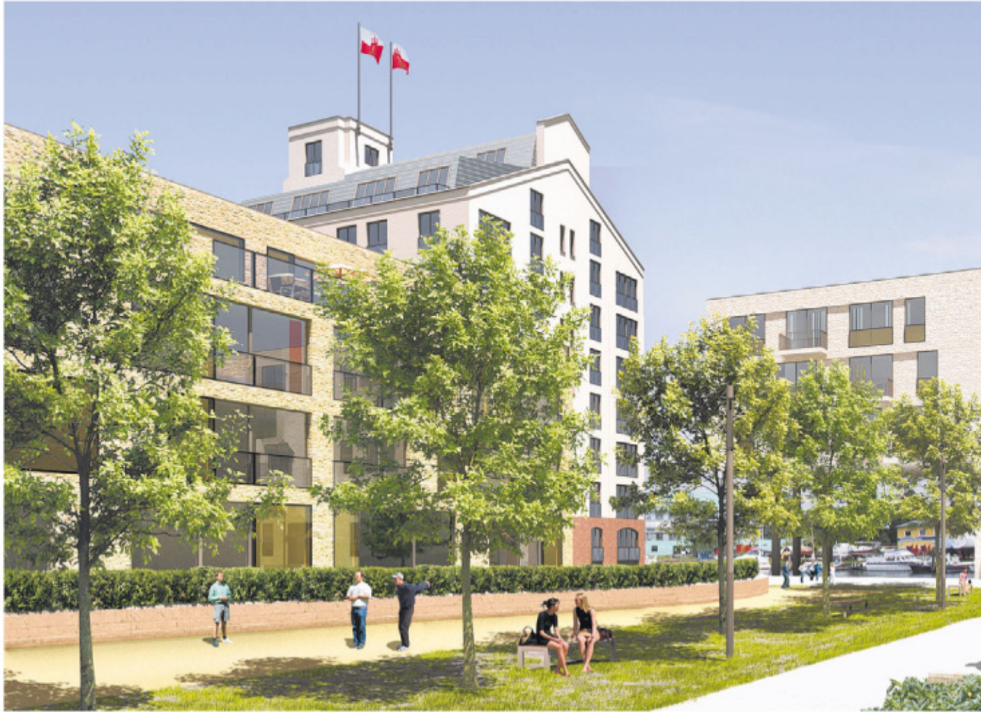
Im Vordergrund der IBA-Park, dahinter die Häuser der Marina auf der Schlossinsel.
